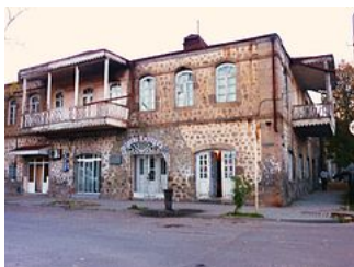
■ Immeuble avec balcon de bois à Goris.
