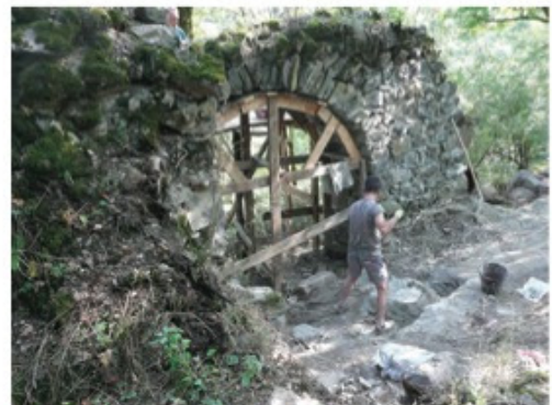
Dantzaparakh : consolidation de la grande arche.
